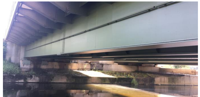
Bild 1 Brückentragwerk für Messfahrten, Untersicht
